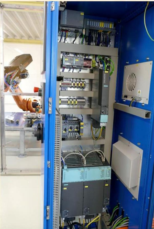
Diesen Schaltkasten entwickelte Herr Gauli zusammen mit der Firma Siemens. Er kann 10 Roboter steuern, die zusammenarbeiten.
